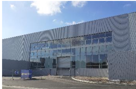
Martignas - Jonctionnement bâtiments 1 et 2
